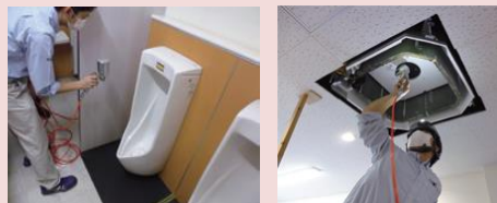
専門の技術スタッフが施工いたします
